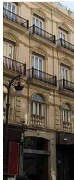
Fachada del edificio de la sede central de Broseta Abogados en Valencia.
